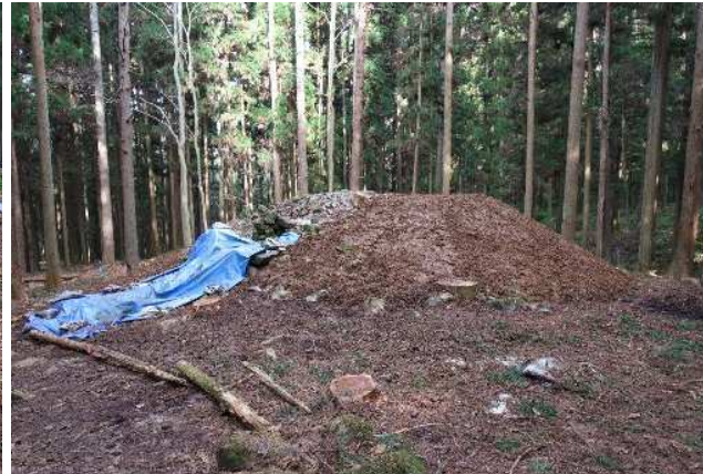
172号墳 令和5年度整備工事完了状況 斜面上方側
