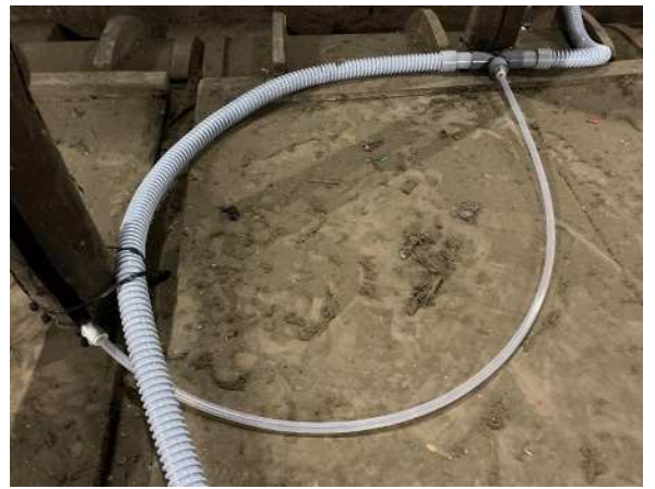
高感度煙検知器の設置
