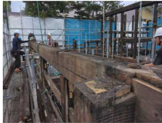
部材解体作業(R5年度修理工事中)
