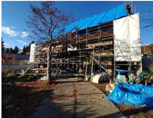
全景(R5年度修理工事中)
