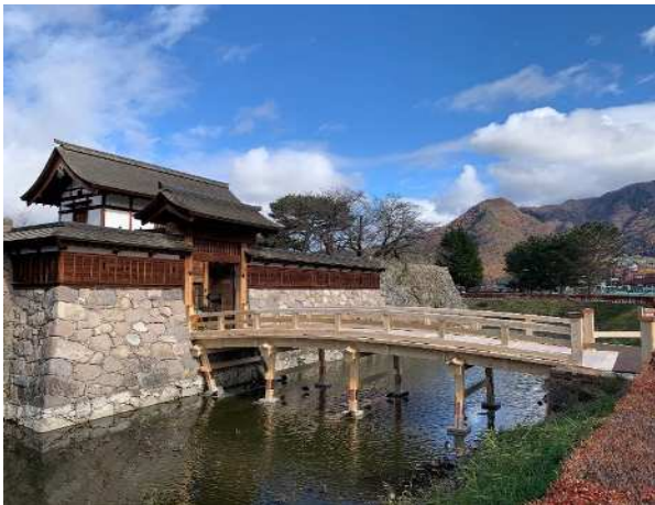
太鼓門前橋外整備工事(太鼓門前橋)
