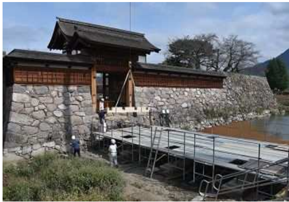
松代城跡 太鼓門前橋整備工事
