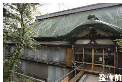
宿坊の茅葺屋根修理
