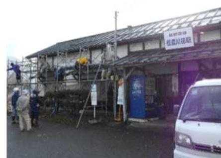
住民による駅舎壁面塗装の様子
