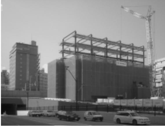
5階までのコンクリート打設が完了し、現在は6～8階の鉄骨組み立て作業中です。来年9月末の竣工に向け、工事は順調に進んでいます。
