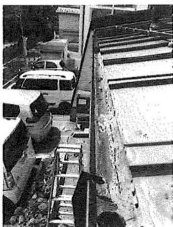
(雨樋)枯れ葉や泥の掃除
