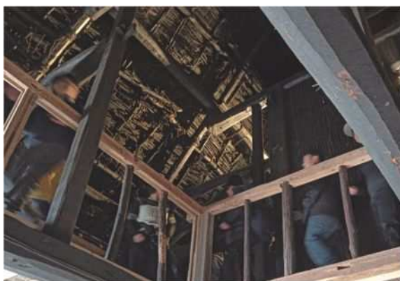
古民家の屋根裏にのぼって大きな梁を見る
