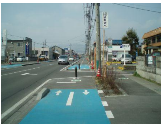
■自転車道の整備（運動公園通り線）
