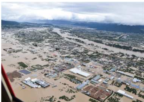
令和元年東日本台風災害の被災状況 浸水災害
