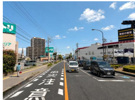
国道18号 上高田北交差点付近
