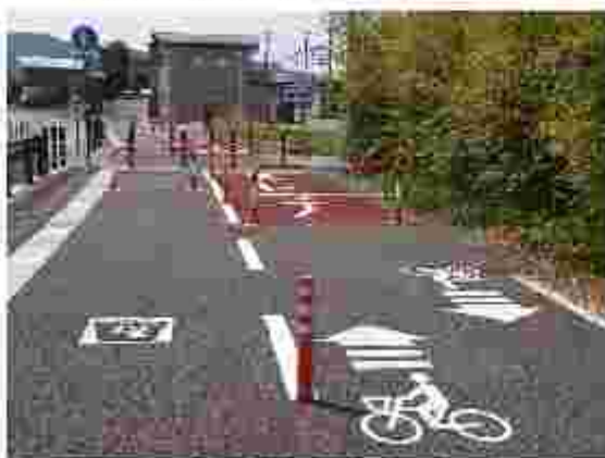
写真 自転車歩行者専用道路の整備例 （千曲川新道）
