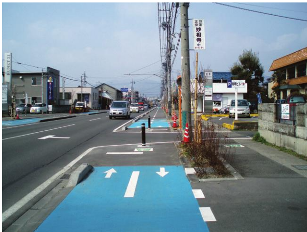
自転車道の整備例（運動公園通り線）
