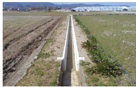
農業用水路の改修
