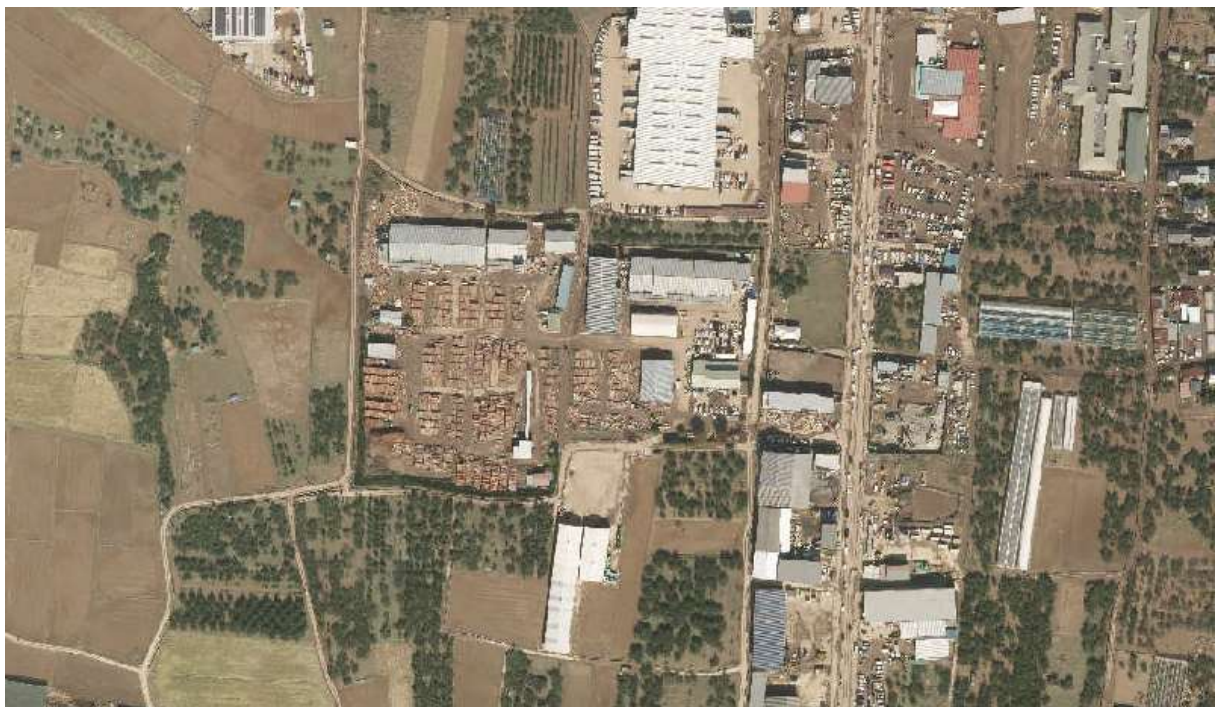
令和元年10月の東日本台風で冠水し、泥が堆積した北信木材センター（令和2年1月10日撮影）
