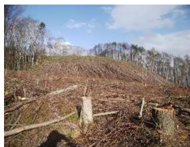
主伐（皆伐）作業現場
