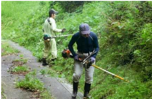
ほ場進入路の維持作業
