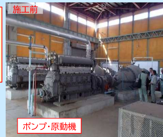
県営農村地域防災減災事業(湛水防除)
