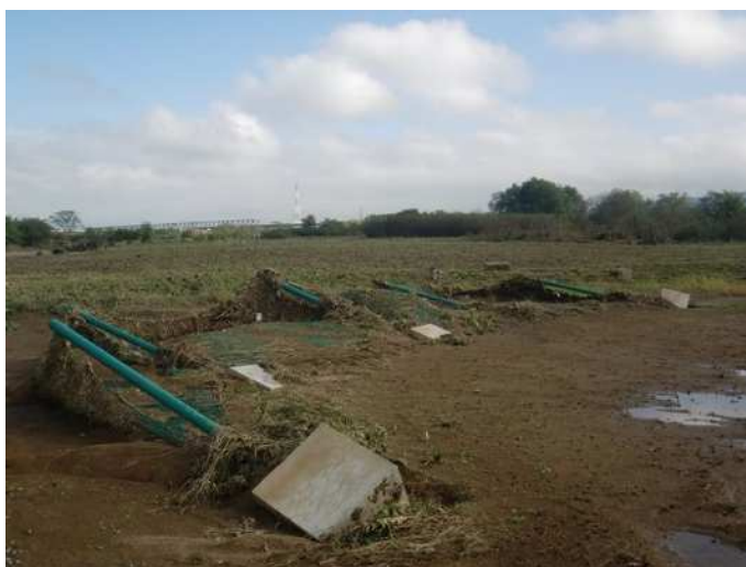
水害後の塩崎運動場（令和2(2020)年廃止）
