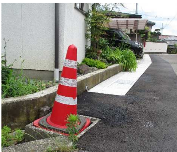
【施工範囲端部の状況】
