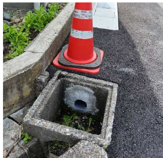
【既設樹開口部】
