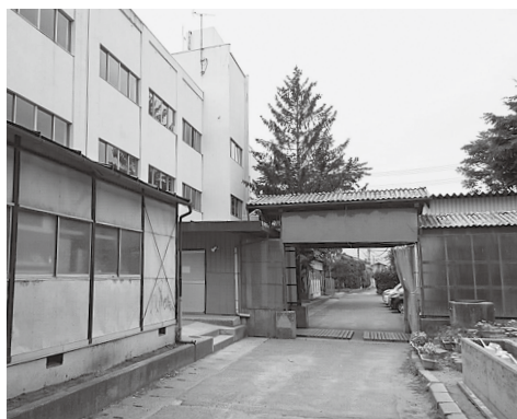
市道と渡り廊下が交差している古牧小学校
