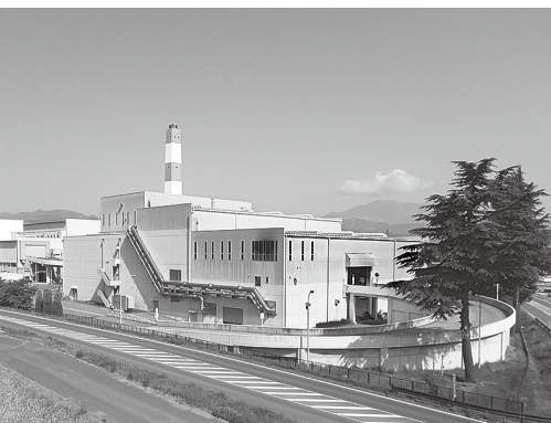
火災のあった資源再生センター
