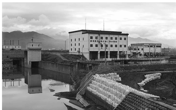
被災した浅川第一・第二排水機場
