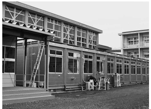
豊野中学校の仮設校舎
