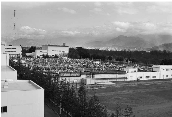
市の下水処理施設「東部浄化センター」
