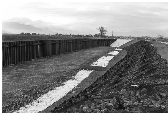
仮復旧工事が完了した千曲川の堤防
