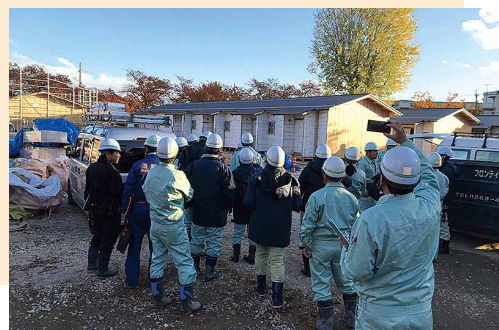
若槻団地に建設中の仮設住宅
