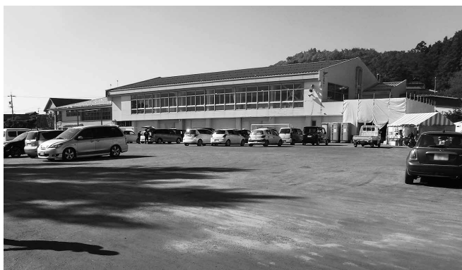
発災直後から避難所となった豊野西小学校の体育館
