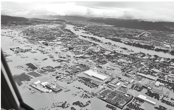
千曲川の堤防が決壊した長沼地区
