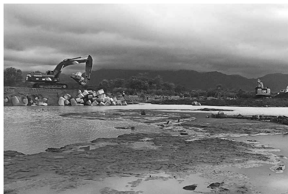
決壊した千曲川堤防の仮復旧工事の様子
