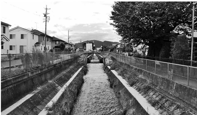
早期着手が待たれる北八幡川の未改修区間
