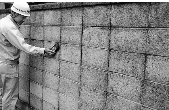
通学路等のブロック塀を点検する様子
