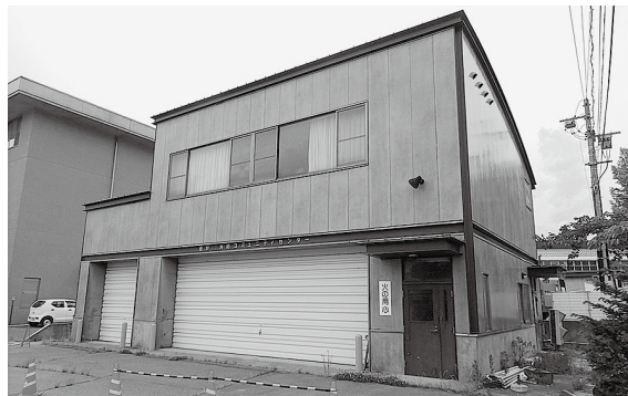
消防分署として計画している豊野消防コミュニティセンター及び豊野支所
