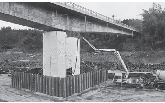
長寿命化を目的とした橋りょう修繕（信州新町平三水橋）
