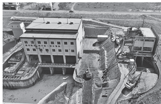
被災した浅川第一排水機場は解体の上、浅川第二排水機場横に新設する
