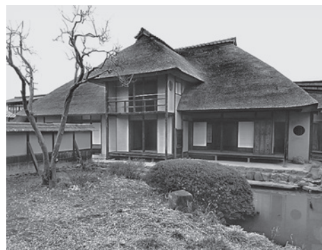
保存修理工事が終了した 旧横田家住宅
