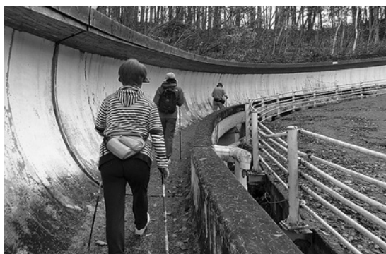
製氷休止後、腐食等対策の上ノルディックウォーキングコースとして利用されているスパイラル
