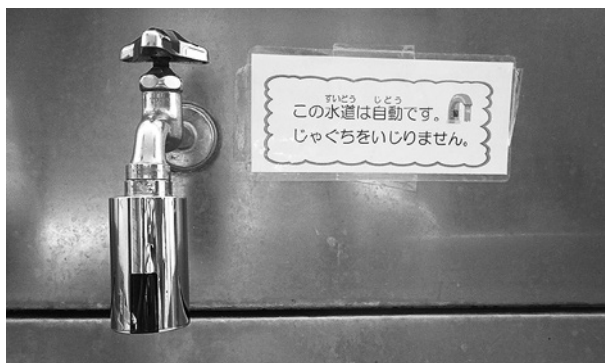
昨年度設置したセンサー式自動水栓。既存の水道蛇口に取り付けるタイプとなっている
