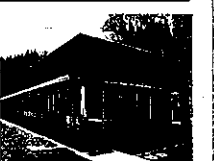
▲シブ工加工センター外観
