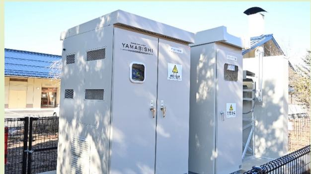
屋外に設置した蓄電池設備(145kw)
