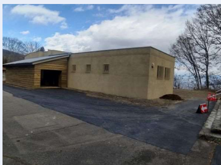
※新設されたライオン舎
