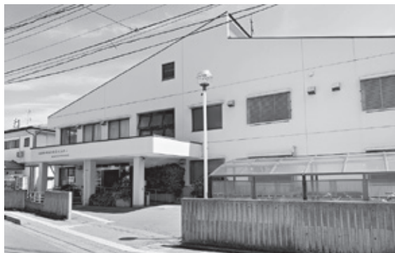
建設から40年が経過し、今年度、長寿命化工事を施行する長野市障害者福祉センター
