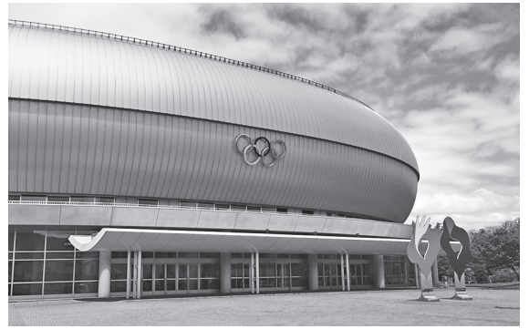
新B1リーグ参入に向け、ホームアリーナとして高機能化が必要とされているホワイトリング
