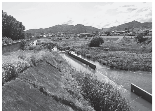
本年度から掘り下げ工事に着手する北八幡雨水調整池
