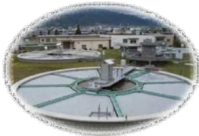
諏訪形浄水場 (県企業局)
