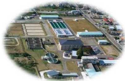
犀川浄水場 (長野市)
