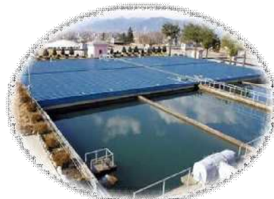
染屋浄水場 (上田市)
