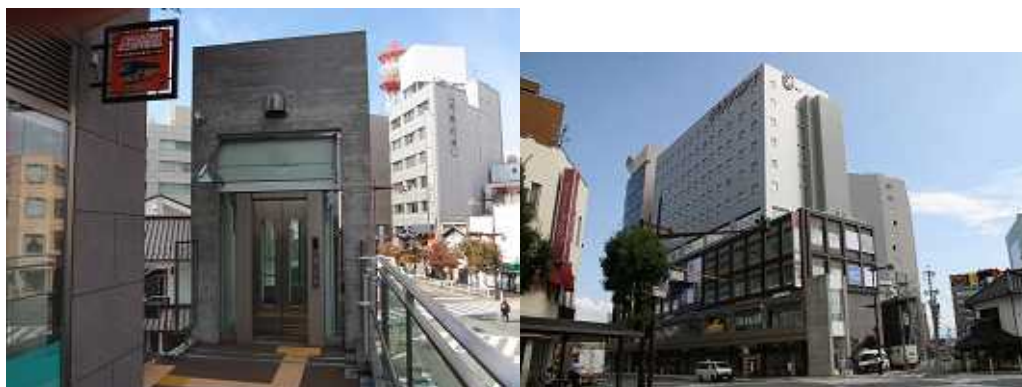
バリアフリーに配慮した長野駅前A - 3地区第一種市街地再開発事業による 再開発ビル「Nacs 未広」
