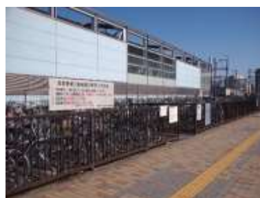
長野駅東口自転車駐車場
