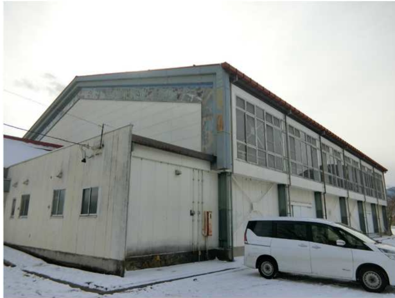
(5)川西体育館全景(上田市)
