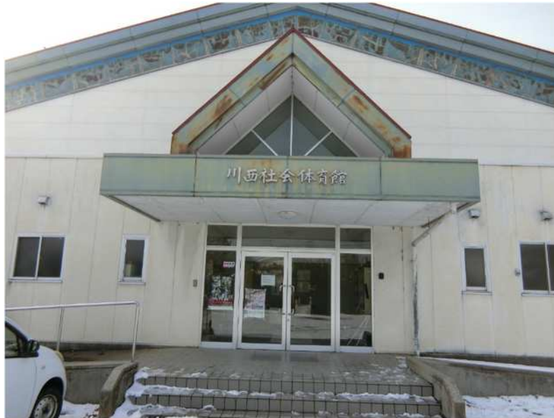
(7)川西体育館正面(上田市)
