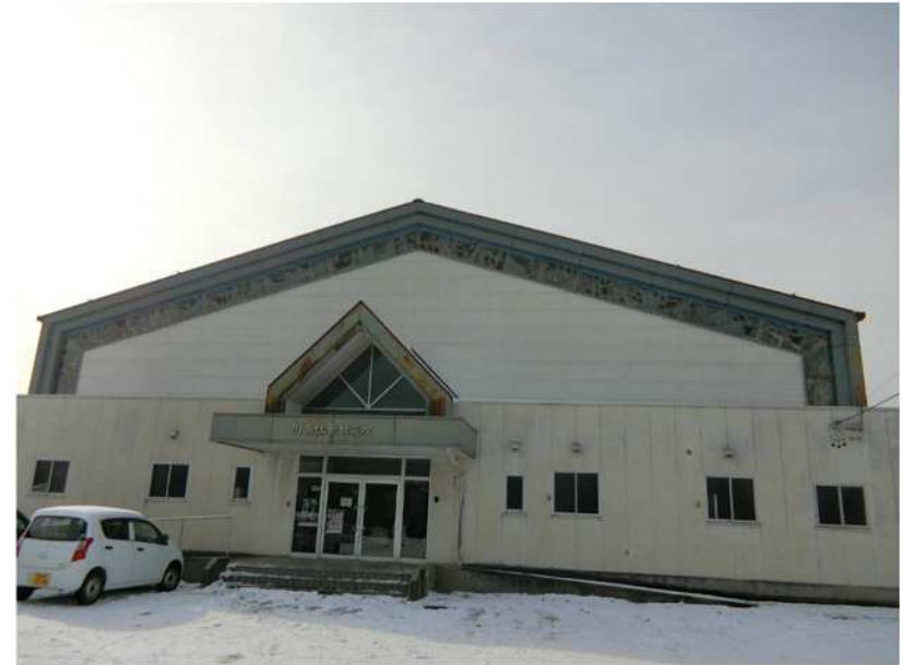
(6)川西体育館正面(上田市)
