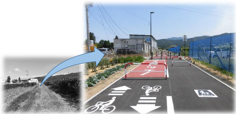
【千曲川新道 自転車道・遊歩道整備 (松代地区)】
