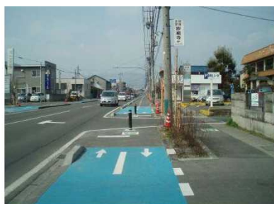
運動公園通り線 (自転車道)
