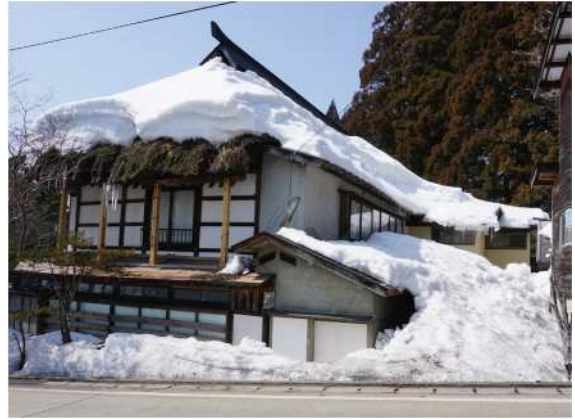
建物北側の雪溜まりの状況
