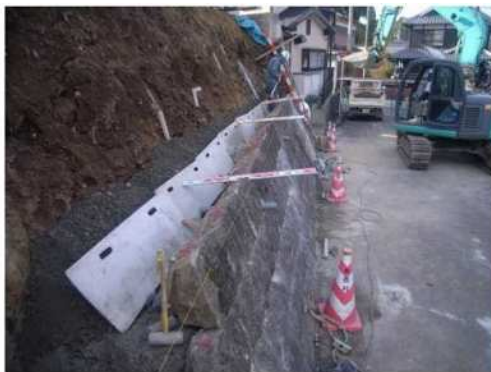
練積で修理した石垣の事例（嬉野市塩田津地区）
