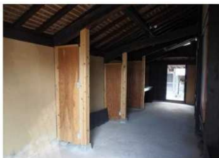
構造用合板による補強壁の例 (鹿島市浜庄津町浜金屋町地区)
