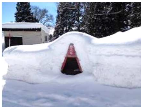
中社地区での防火水槽の積雪対策
