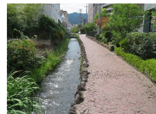
用水を活用した親水空間 (長野市 南八幡川)
