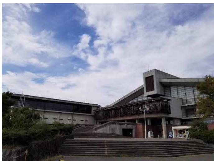
前回の「やまびこ国体」で建設された長野運動公園総合運動場 総合体育館（昭和53(1978)年 竣工）
