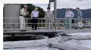
諏訪形浄水場
