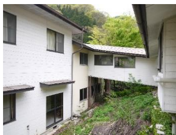
・ 連絡通路 (右が北棟、左が南棟)
