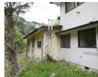
・南棟（奥側が浴室）
