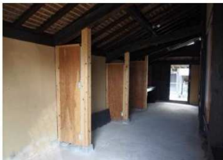
写真 15 土間に構造用合板による補強壁を設置 あえて仕上げを施さず後補の補強壁と分かるようにした (鹿島市浜庄津町浜金屋町地区)
