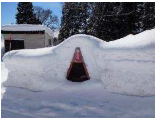
(参考) 中社地区での防火水槽の積雪対策（左）と積雪時でも吸水を容易にするサクシオンパイプの事例（右）
