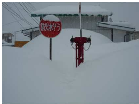
(参考) 中社地区での防火水槽の積雪対策（左）と積雪時でも吸水を容易にするサクシオンパイプの事例（右）
