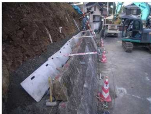
写真 42 練積で修理した石垣（嬉野市塩田津地区）
