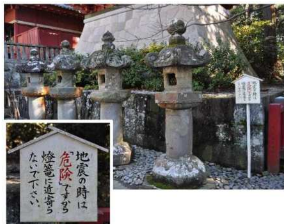
写真 39 石灯笼の危険性明示看板
