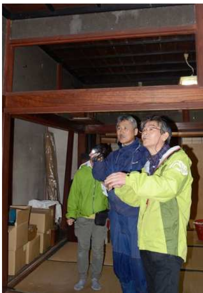
被災物件を調査するヘリテージマネージャー
