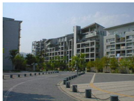
— 市営住宅 今井団地 —
