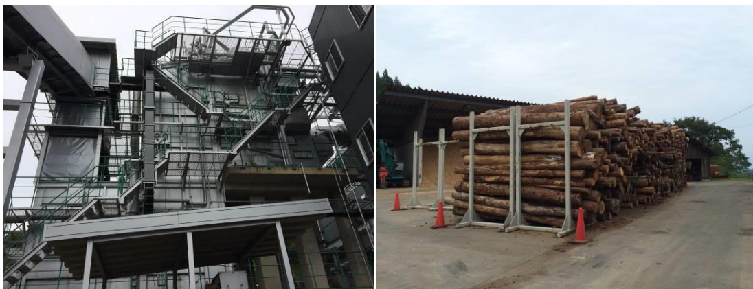
木質バイオマス発電所
