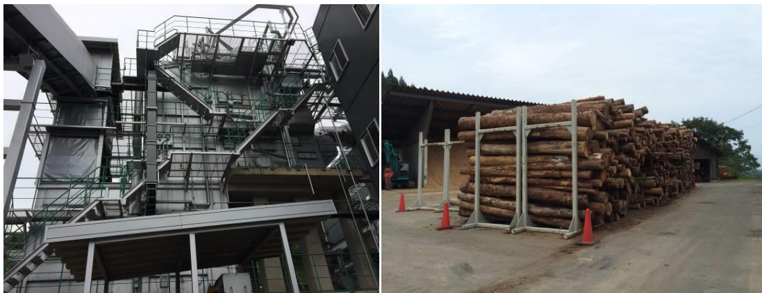
木質バイオマス発電所
