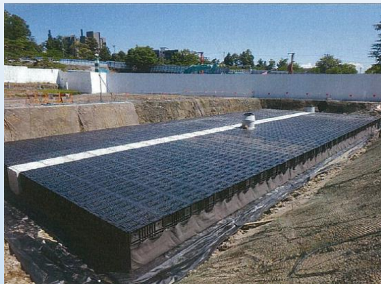
公園貯留 城山公園
