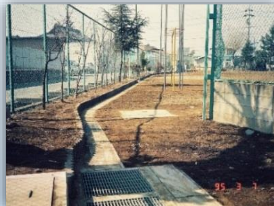
校庭貯留 朝陽小学校
