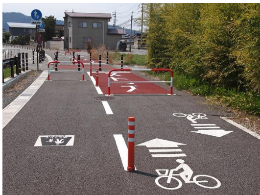
写真9 自転車歩行者専用道路の整備例（千曲川新道）
