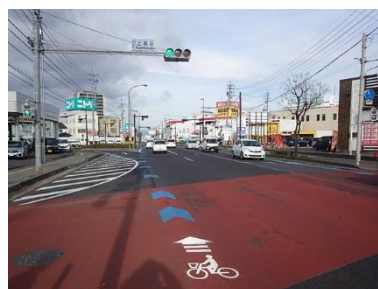
国道 18 号 上高田交差点 (車道混在)
