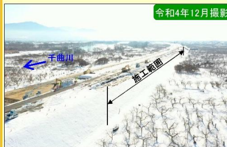
現地施工状況①
