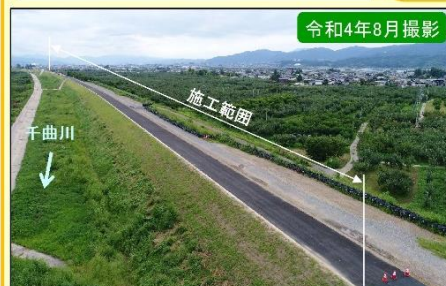
現地施工状況①
