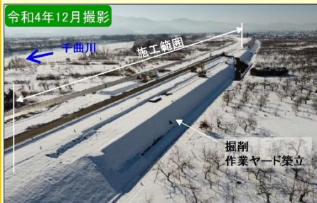
現地施工状況①
