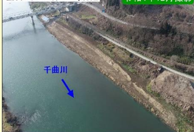
現地施工状況①
