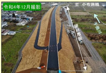
現地施工状況②
