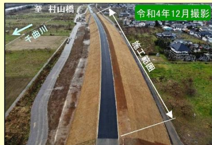
現地施工状況①
