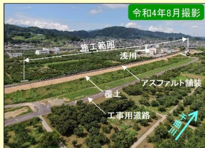
現地施工状況①
