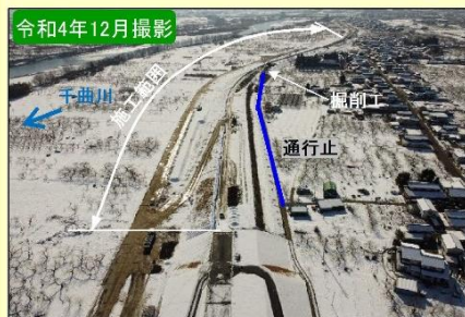
現地施工状況①
