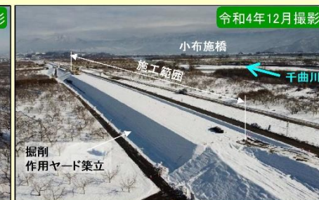
現地施工状況②
