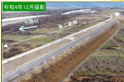
現地施工状況①
