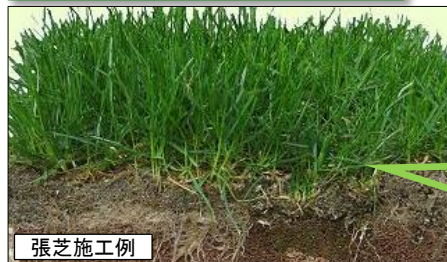
張芝により耐侵食性を確保
