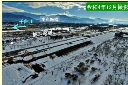
現地施工状況②
