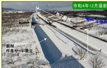
現地施工状況②
