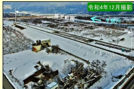
現地施工状況①
