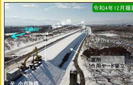
現地施工状況①
