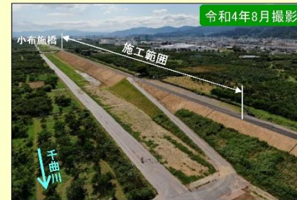
現地施工状況②
