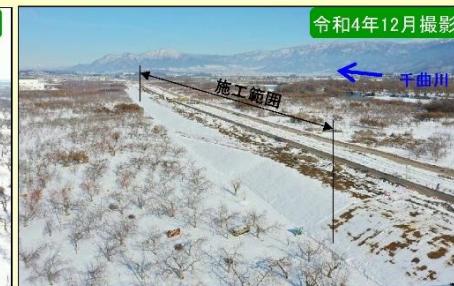
現地施工状況②
