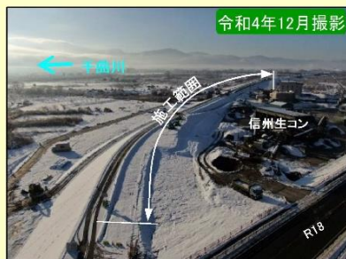
現地施工状況②
