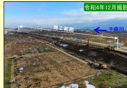
現地施工状況①
