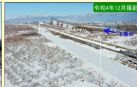
現地施工状況②
