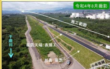
現地施工状況①
