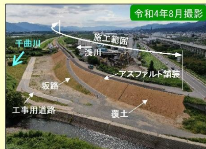
現地施工状況②
