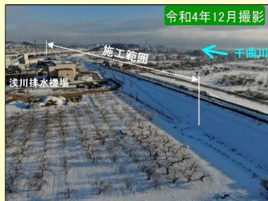
現地施工状況①
