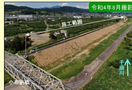
現地施工状況①
