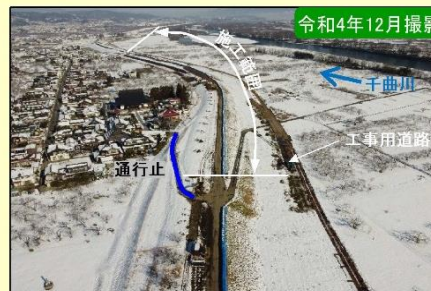
現地施工状況②
