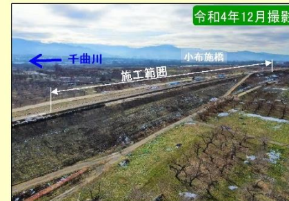
現地施工状況②
