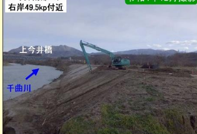
現地施工状況②
