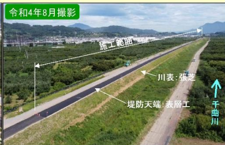
現地施工状況②
