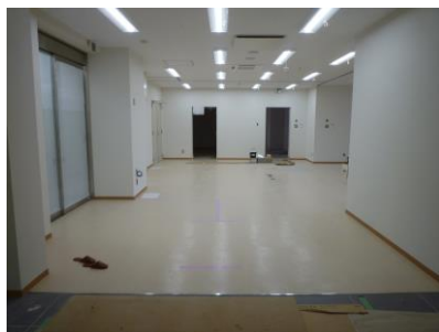
執務室施工状況
