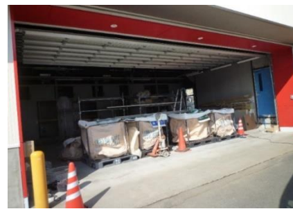
車庫施工状況
