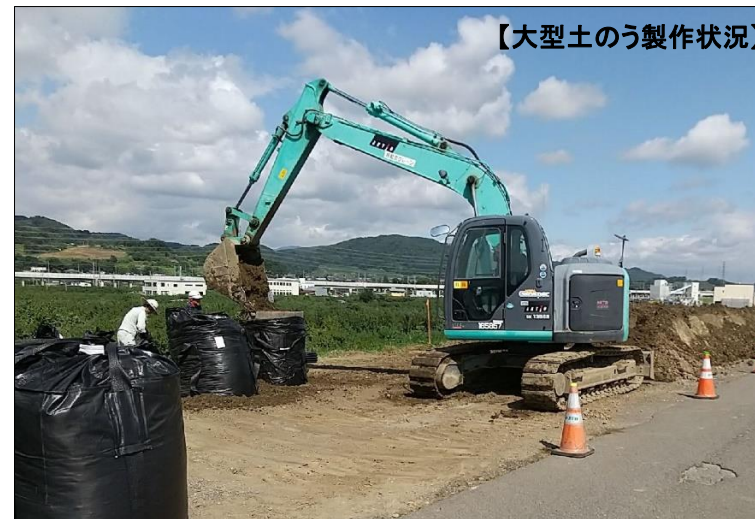
【大型土のう設置状況】
