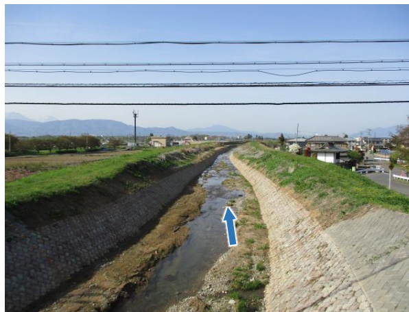
土砂撤去作業完了 R4.4.25
