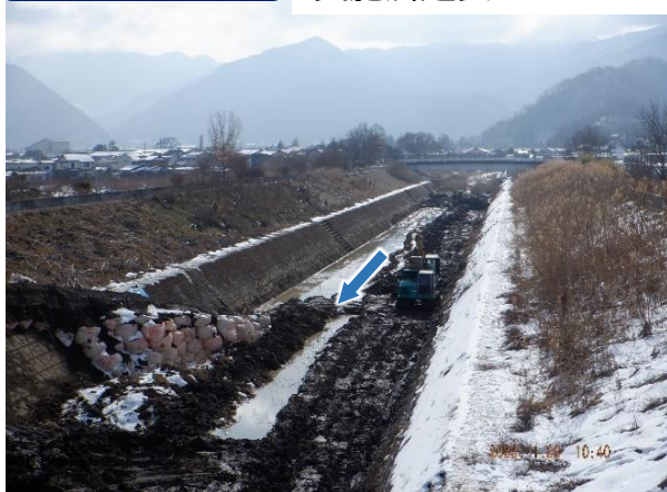
土砂撤去作業の状況 R4.1.28
