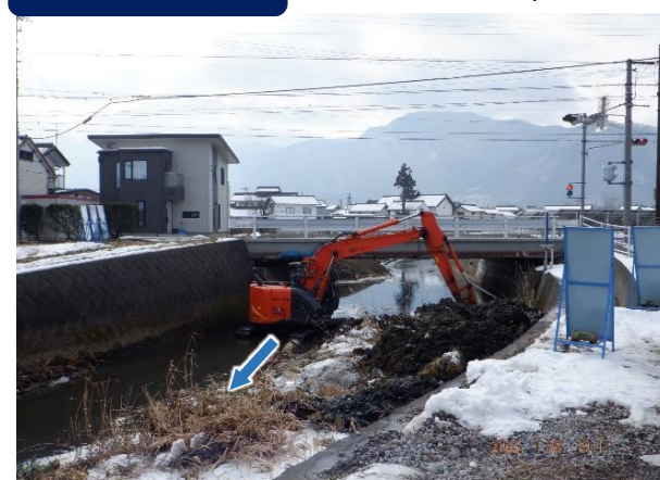
土砂撤去作業の状況 R4.1.28
