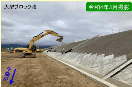
現地施工状況②
