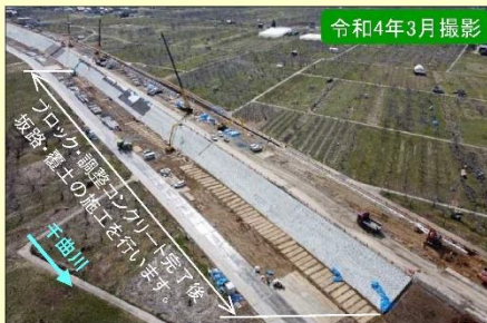
現地施工状況①
