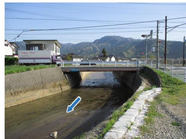
土砂撤去作業完了 R4.4.25
