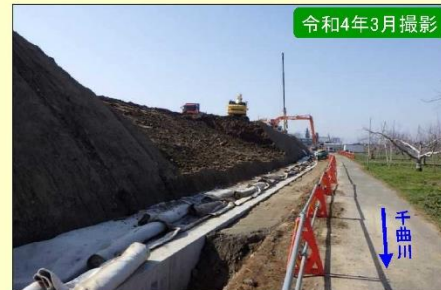
現地施工状況②
