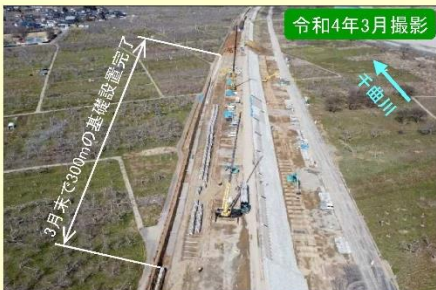
現地施工状況②
