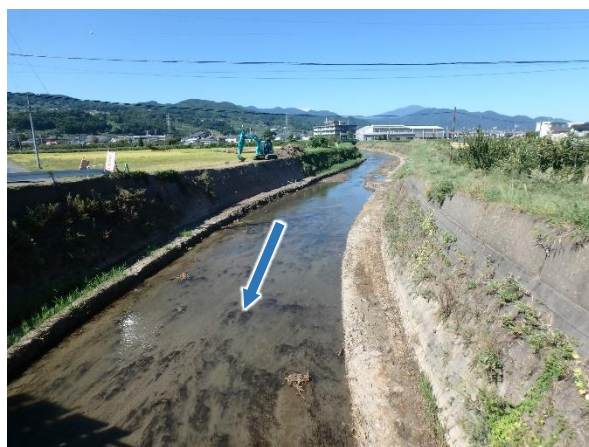
土砂撤去作業実施中 R3.9
