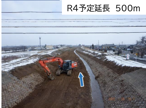
土砂撤去作業の状況 R4.1.28
