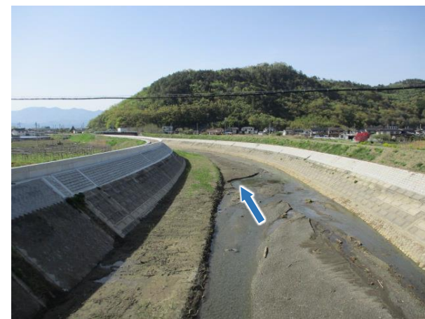
土砂撤去作業完了 R4.4.25
