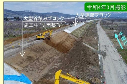
現地施工状況②
