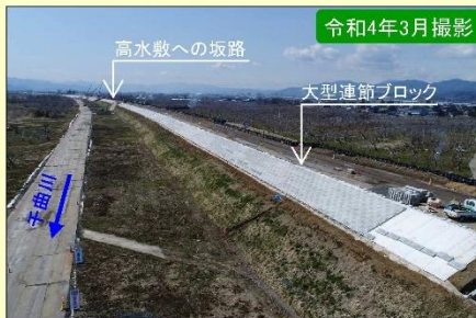
現地施工状況①
