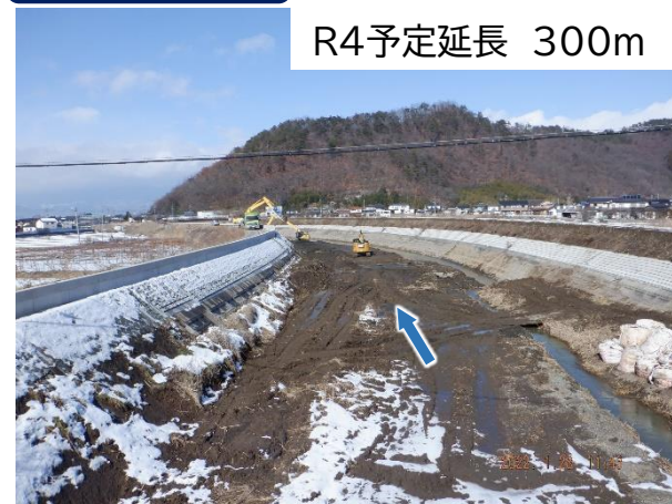
土砂撤去作業の状況 R4.1.28
