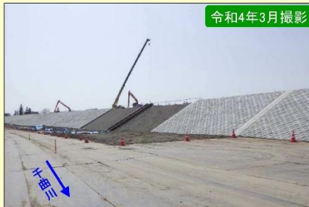
現地施工状況①
