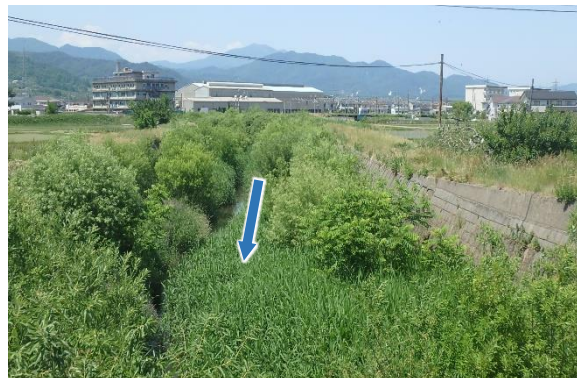
土砂撤去作業前の状況 R2.6
