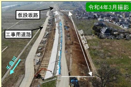
現地施工状況①
