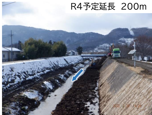
土砂撤去作業の状況 R4.1.28
