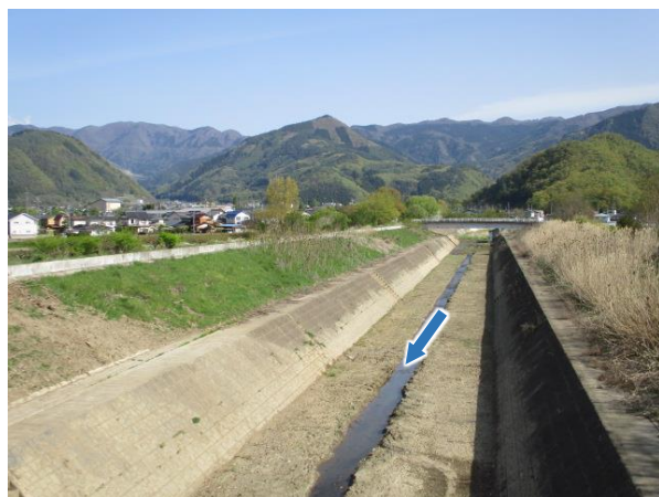
土砂撤去作業完了 R4.4.25
