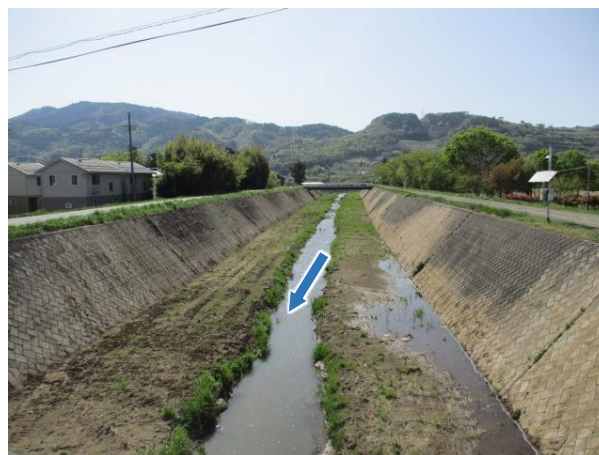
土砂撤去作業完了 R4.4.25
