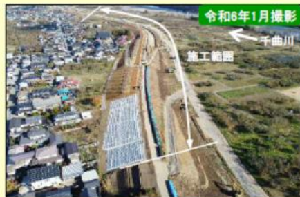
現地施工状況①
