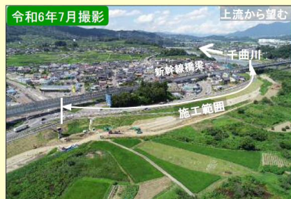
現地施工状況①
