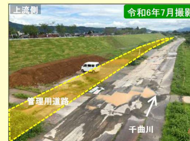
現地施工状況①
