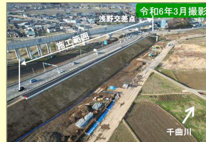
現地施工状況①
