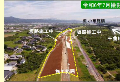
現地施工状況①
