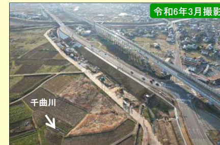
現地施工状況②
