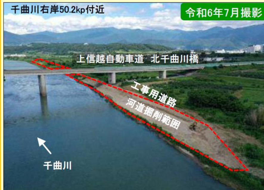
現地施工状況①
