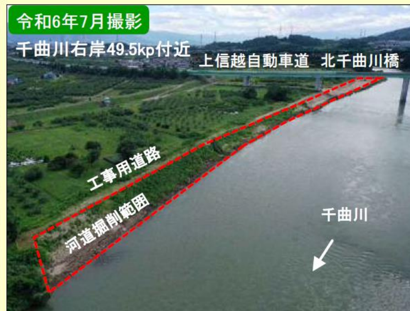
現地施工状況②
